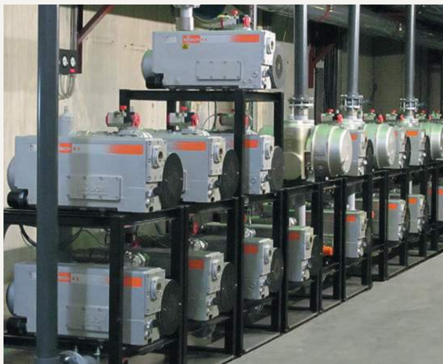
Sistema per il vuoto centralizzato per 30 linee di confezionamento con macchine termoformatrici
